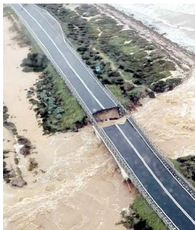
Il ponte crollato sulla statale 195 tra Cagliari e Capoterra (foto ANSA)
