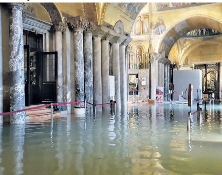
L'acqua alta a Venezia arriva a danneggiare anche gli interni della basilica di San Marco
