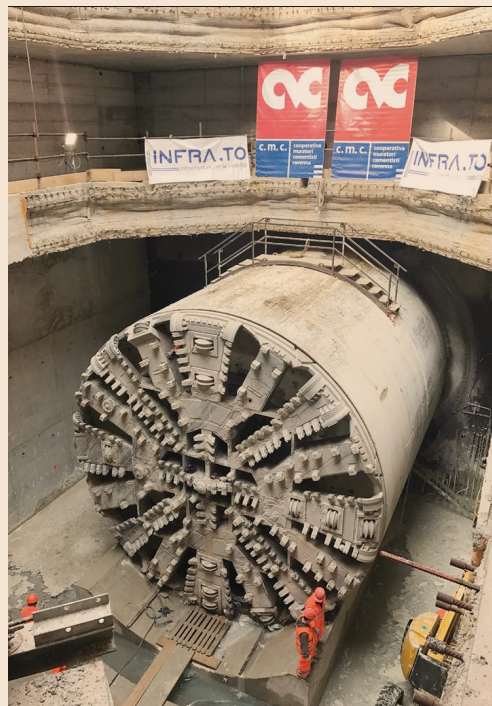
Tunnel boring machine. Una Tbm di Cmc, macchina escavatrice ad alto contenuto tecnologico
