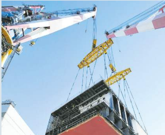
Una fase della costruzione di una nave in un cantiere della Fincantieri
