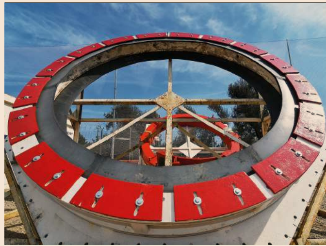
Trans Adriatic Pipeline. La guarnizione della fresa nel cantiere del terminale italiano a Melendugno (Lecce)
